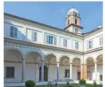
Il complesso di Santa Croce a Bosco Marengo
